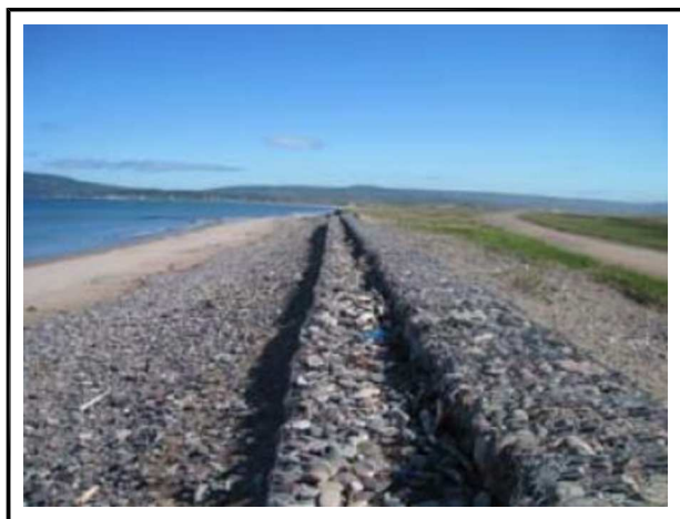
- Gabions sur l'Isthme à la "Dune"- (à l'origine)
